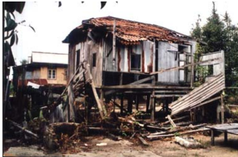
c) Demolition (Nisan Empat, K. Terengganu)
