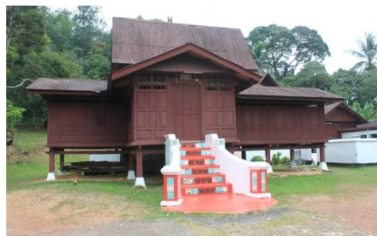
Gambarajah 1.7: Rumah milik Haji Md. Ali Aman di No.2, Kampung Lubok Kepong, Simpang Ampat, Alor Gajah ini telah berusia lebih daripada 100 tahun semasa lawatan pertama pada tahun 2012. Ianya didapati telah diubahsuai kepada sebuah banglo binaan konkrit semasa lawatan kedua pada 2013.
