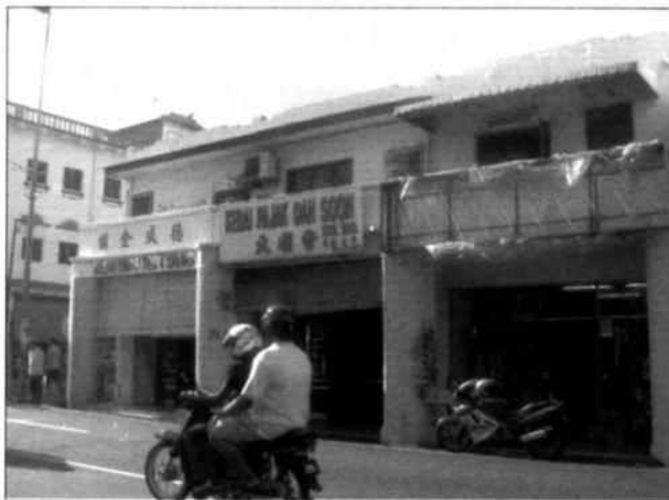
Gf 1.9 : Penggunaan Papan Tanda Yang Tidak Dikawal Saiznya, Menutupi Fasad Bangunan, 2005
