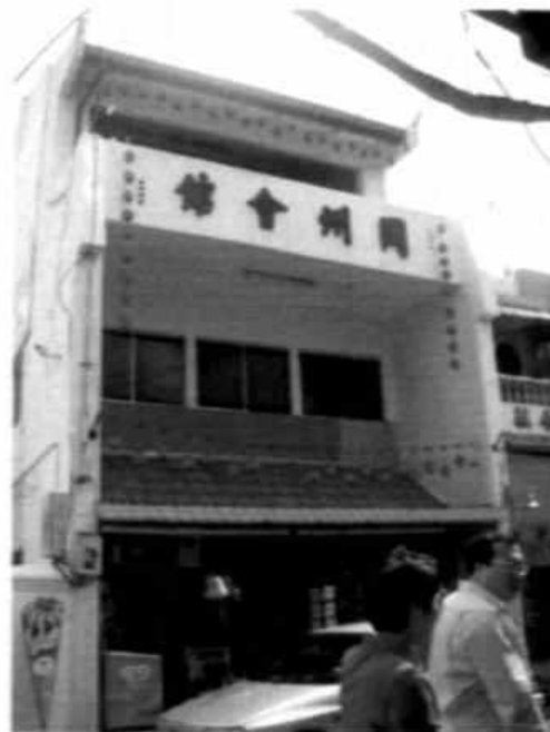
Gf1.12 : Penambahan Tingkat Pada Salah Sebuah Bangunan Di Jalan Tokong, 2007
