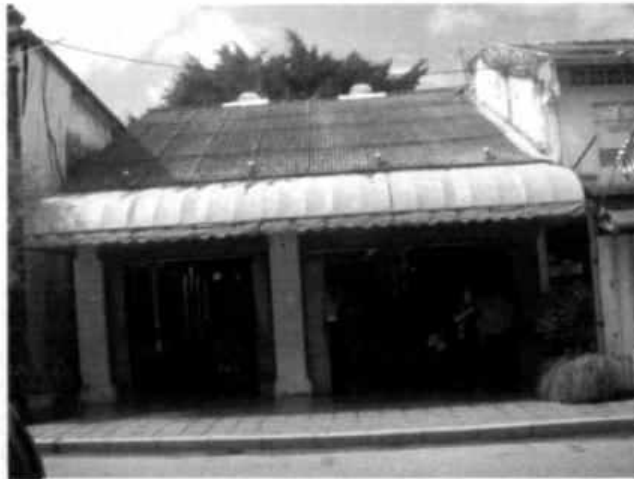
Gf 1.4 : Dua Rumah Kedai Yang Digabungkan Di Jalan Hang Jebat,2007
