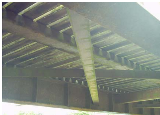
Struktur Bracing Pada Rasuk Jambatan Di Tasik Utm
