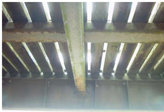
Rectangular Hollow Section (RHS) yang berfungsi sebagai rasuk kedua dan bracing .
