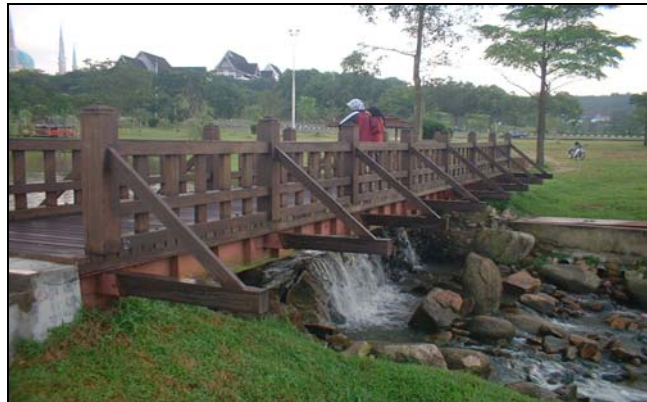
Rajah 4.1: Pandangan Sisi Jambatan
