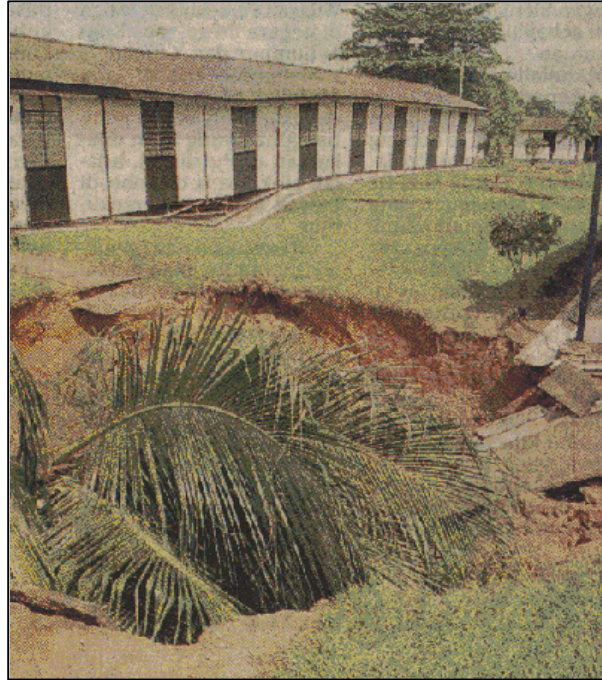
Gambarfoto 1.2d : Kesan Lubang Benam Di sebahagian Bangunan Asrama RAJD (Zaini (Berita Harian), 2000)
