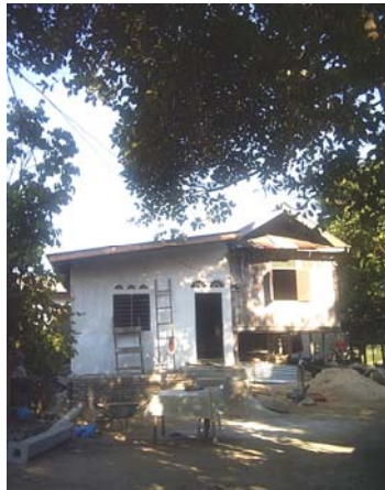
a) New materials (Pulau Ketam)
