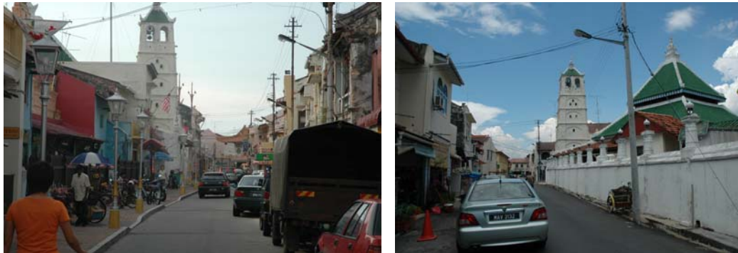
Rajah 5.25: Menara Masjid Kampung Keling memberikan penskalaan kepada jalan Tokong, jalan Tukang Emas, jalan Tukang Besi dan jalan Hang Lekiu
