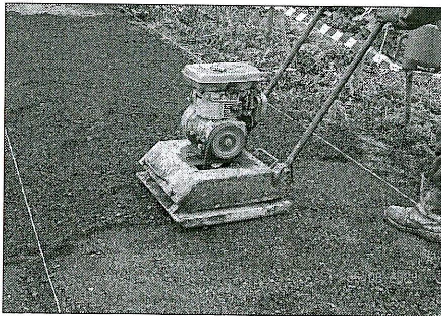
Kerja pemadatan menggunakan pematat plat
