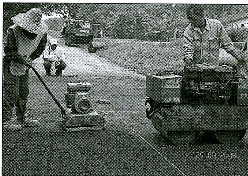
Kerja pemadatan dilakukan serentak
