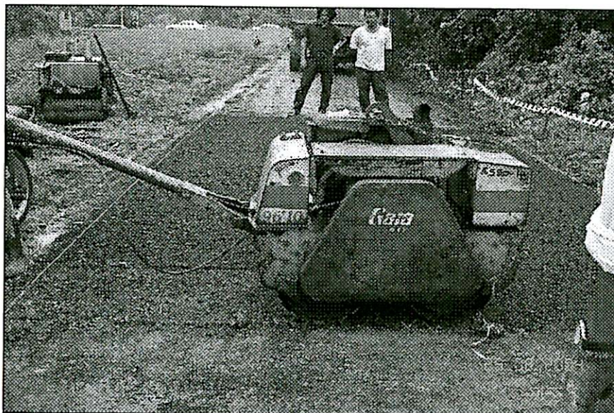
Kerja pemadatan menggunakan pemadat dram
