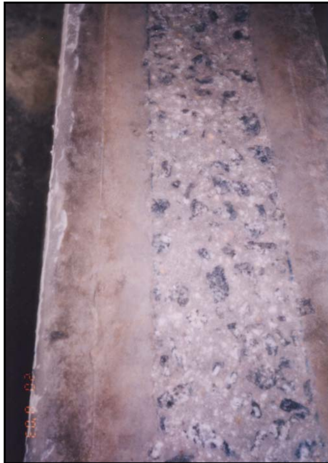
Rajah 3.12: Permukaan rasuk yang telah dikasarkan menggunakan air tool.
