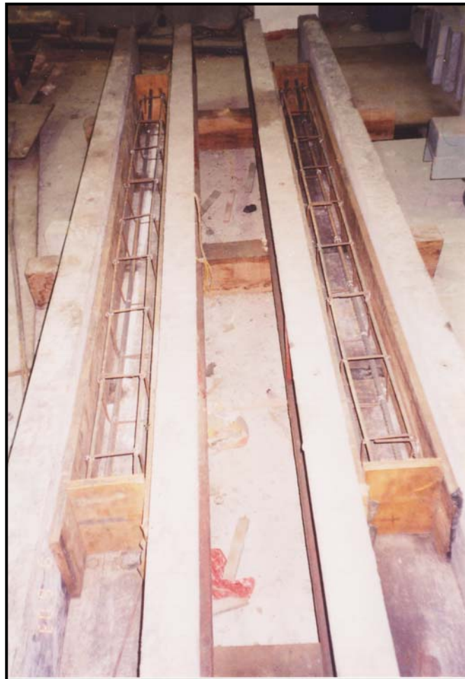
Rajah 3.7 : Tetulang yang telah siap diletakkan dalam acuan kayu dan diperkukuhkan dengan acuan besi
