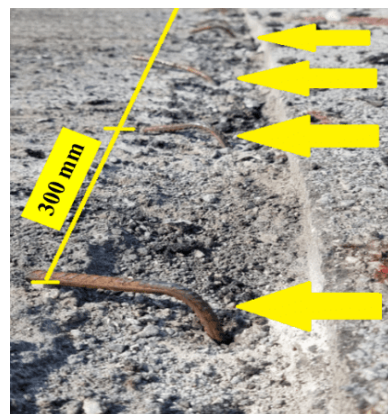
(d) Rebar installation for the joints
